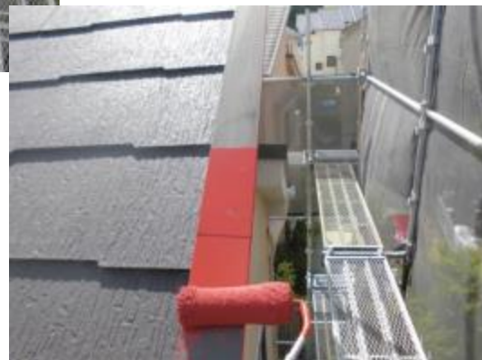
コロニアル周辺板金錆止め塗装→
