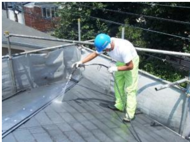
屋根洗浄(埃やカビ・コケを除去) * 高圧・低圧・常圧問わず
