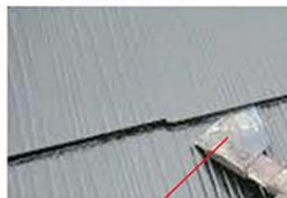
縁切り工具で上下勘合をふさいでいる塗膜を撤去する。
