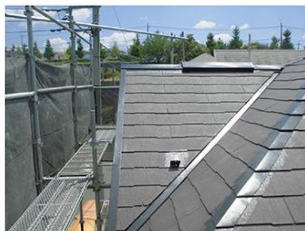
板金部（棟・隅棟・谷・ケラバ・雪止め）塗布状況
