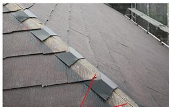
既存差棟前端部をカット
