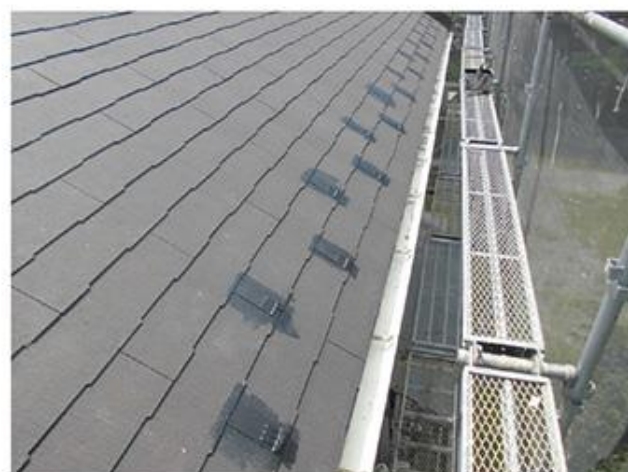
雪止め塗布状況
